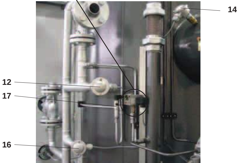
Temperaturfühler, Drucksensor und Dampfdruckbegrenzer Temperaturføler, trykføler og overtrykspresostat
