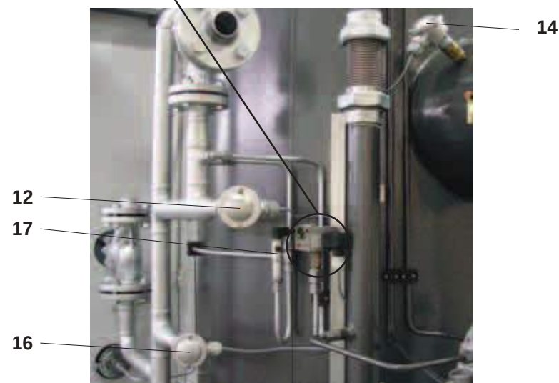
Temperaturfühler, Drucksensor und Dampfdruckbegrenzer Temperaturføler, trykføler og overtrykspresostat
