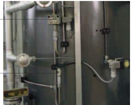
Drucksensor Dampfdruckregelung Trykføler driftspressostat
