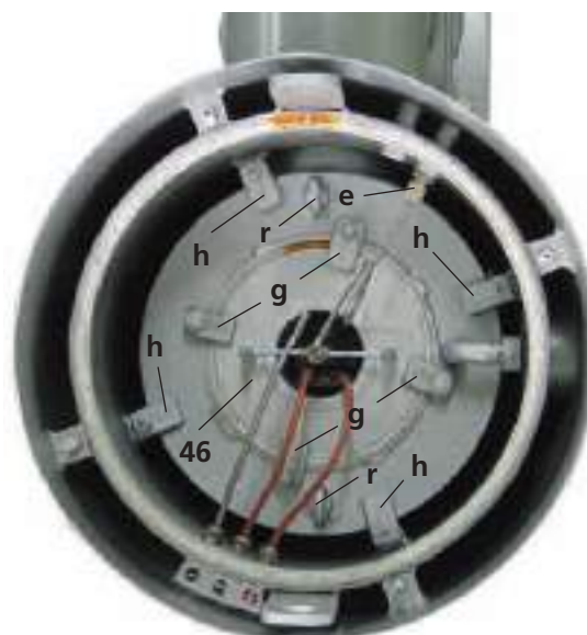
Dampfautomat mit Ölfeuerung ohne Zwischendeckel Dampgeneratoren med oliefyring uden mellemdækslet
